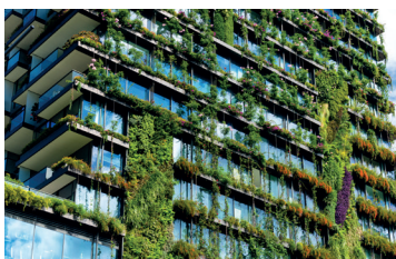
Construction d'un bâtiment à énergie positive (aligné sur les labels français et européens).
