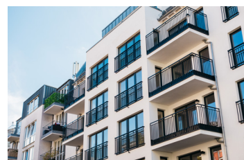
Rénovation pour améliorer l'isolation et diminuer la consommation d'énergies.
