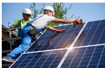
Installation d'un panneau photovoltaïque sur le toit d'une résidence.
