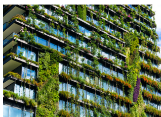
Construction d'un bâtiment à énergie positive (aligné sur les labels français et européens).
